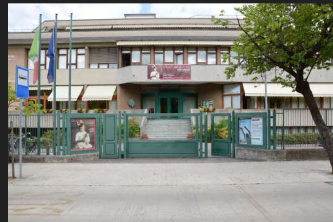
FIGURA 24 Cancelli e spazio esterno della casa dello studente
