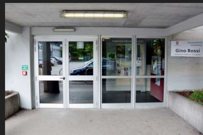
FIGURA 38 Ingresso accessibile del polisportivo
