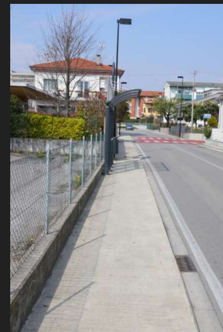
FIGURA 30 Marciapiede lungo la via
