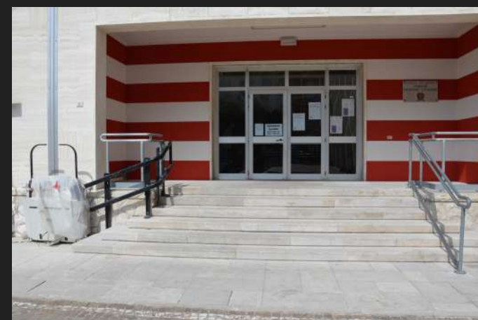
FIGURA 8 Ingresso del liceo con montascale
