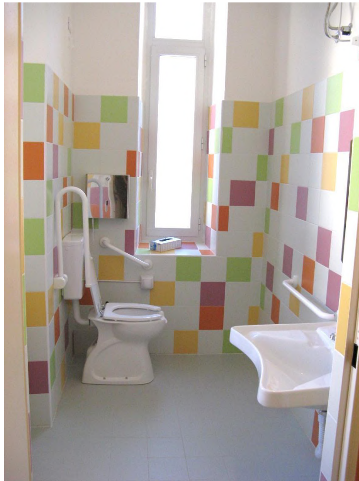
Spazio libero anteriore al lavabo inferiore a 80 cm al 2° e 3° piano del blocco bagni a fianco dell'ascensore.
