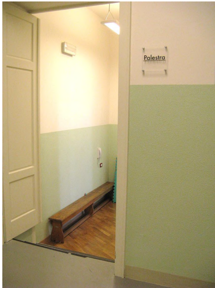
Gradini pericolosi non adeguatamente segnalati, segnale fai-da-te delle maestre.
