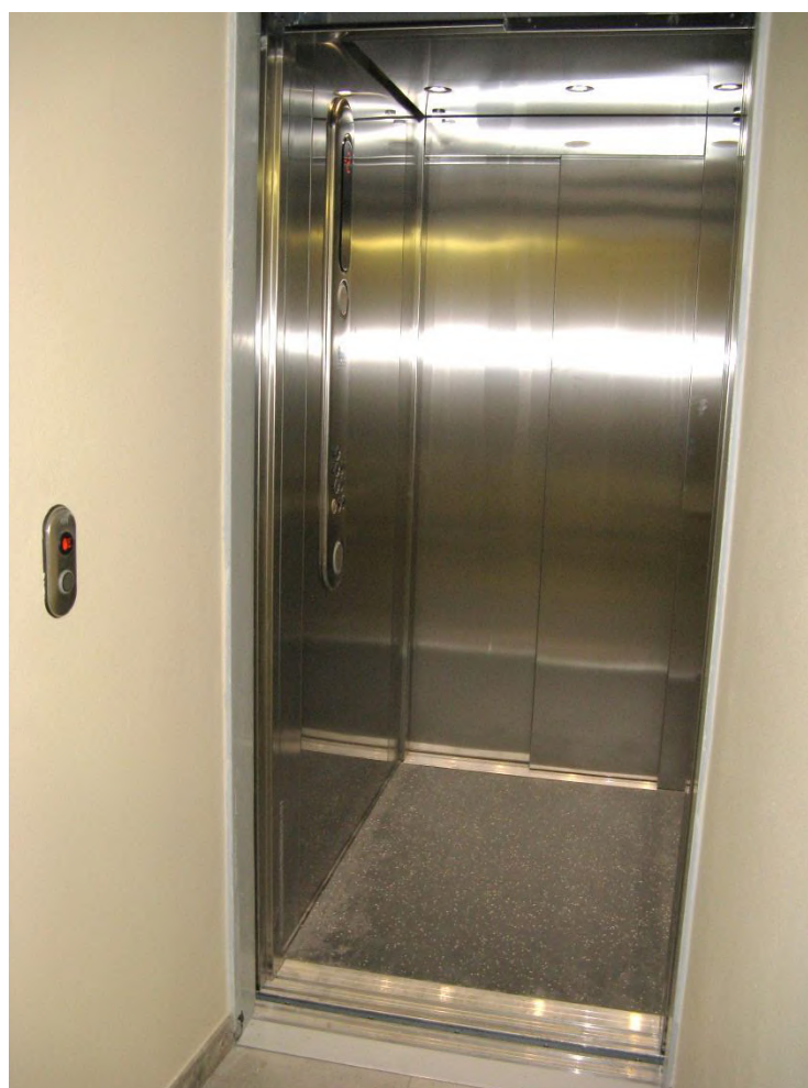
Dimensioni ascensore corrette e pulsanti con numeri in rilievo e placchetta Braille.
