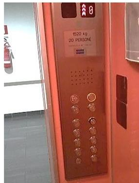
Il terzo ascensore, invece, non è accessibile in quanto la larghezza d'accesso è di soli 70 cm, ed i pulsanti di chiamata sono posti troppo in alto; nemmeno le dimensioni della cabina sono sufficienti ma la pulsantiera di comando ha un'altezza conforme.
