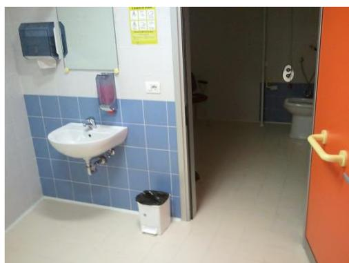
All'interno gli spazi di manovra sono abbondanti, il wc è dotato di due maniglioni verticali, uno orizzontale all'altezza di 80 cm ed uno ribaltabile sul lato del muro collocato all'altezza di 70 cm, quindi troppo basso per l'usabilità; tutti i maniglioni hanno il diametro e la distanza dal muro corretti.
